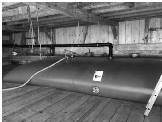
Figure 6. Citerne souple alimentées par une toiture
